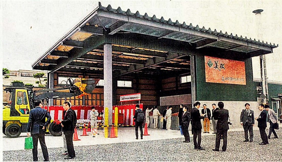
導入された木質バイオマスチップサイロとボイラーの設備＝17日、あわら市舟津のあわら温泉美松
