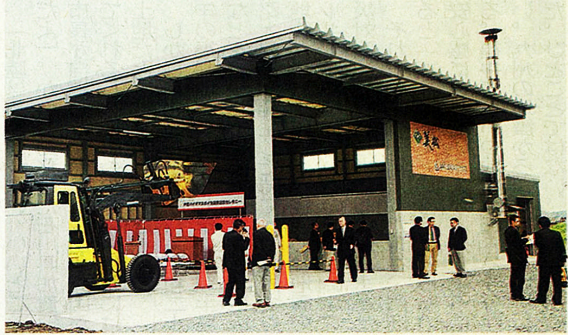
温泉旅館「美松」の熱源として稼働した木質チップボイラー施設＝あわら市舟津で
