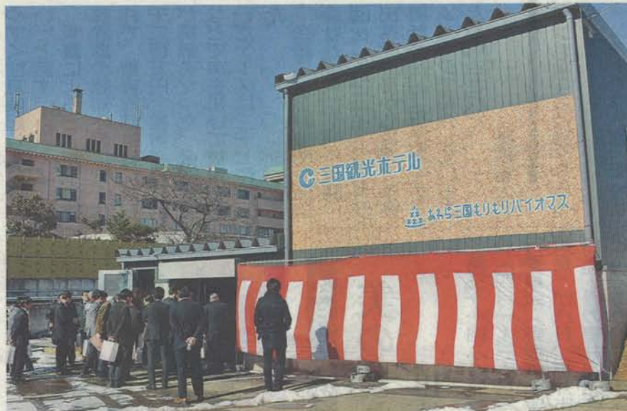
エネルギーの地産地消を目的に新設されたポイラー施設＝坂井市三国町緑ヶ丘4丁目で
